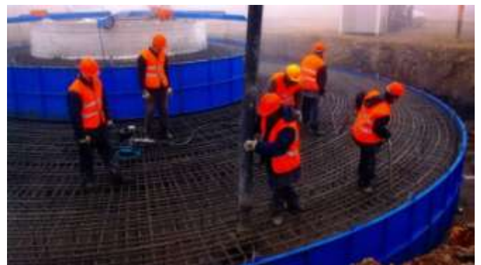
Κατασκευή θεμελίωσης πύργου ύψους 85m για ανεμογεννήτρια τύπου ENERCON E70
